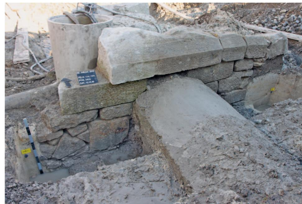
Abb. 225 Cham-Bachgraben. Grabungsfoto vom 11. November 2010. Blick auf die südliche Brückenstirn in den Feldern 114 und 134. Der Betonsockel im Bildvordergrund ist vermutlich beim Eindolzen des Bachgrabens in den 1960-er Jahren erstellt worden.
