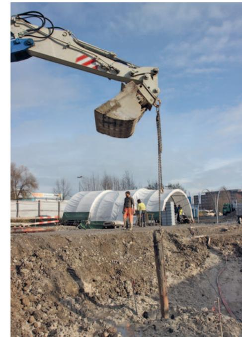
Abb. 215 Cham-Bachgraben. Grabungsfoto vom 25. November 2010. Ein Pfahl der Strassensubstruktion wird mit dem Bagger herausgezogen.
