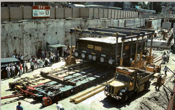
Chargement du caisson renfermant une partie du site magdalénien de Monruz (dimensions du bloc : 6 x 11 m). Le caisson de palplanches est fixé à un pontique de levage qui repose sur deux rangées de quatre vérins accouplés prenant appui sur des rails de translation.
