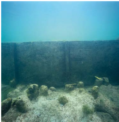
Abb. 38 Cham-Eslen. Die temporären Erosionsschutzmassnahmen nach der Grabungsetappe 1998/99 bestanden aus mit Kantenhölzern befestigten, senkrecht aufgestellten Brettern, die das Profil und die Schichten bis zur nächsten Grabungskampagne schützen sollten.
