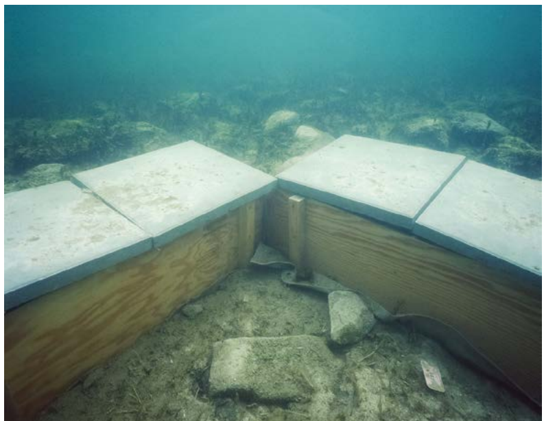
Abb. 41 Cham-Eslen. Verbesserter Profilschutz 2005: Ein Geotextil (in Bildmitte am Seegrund vor dem Profil sichtbar) und Bretter schützen das Profil, die Profilkante ist zusätzlich mit Gartenbetonplatten abgedeckt.
