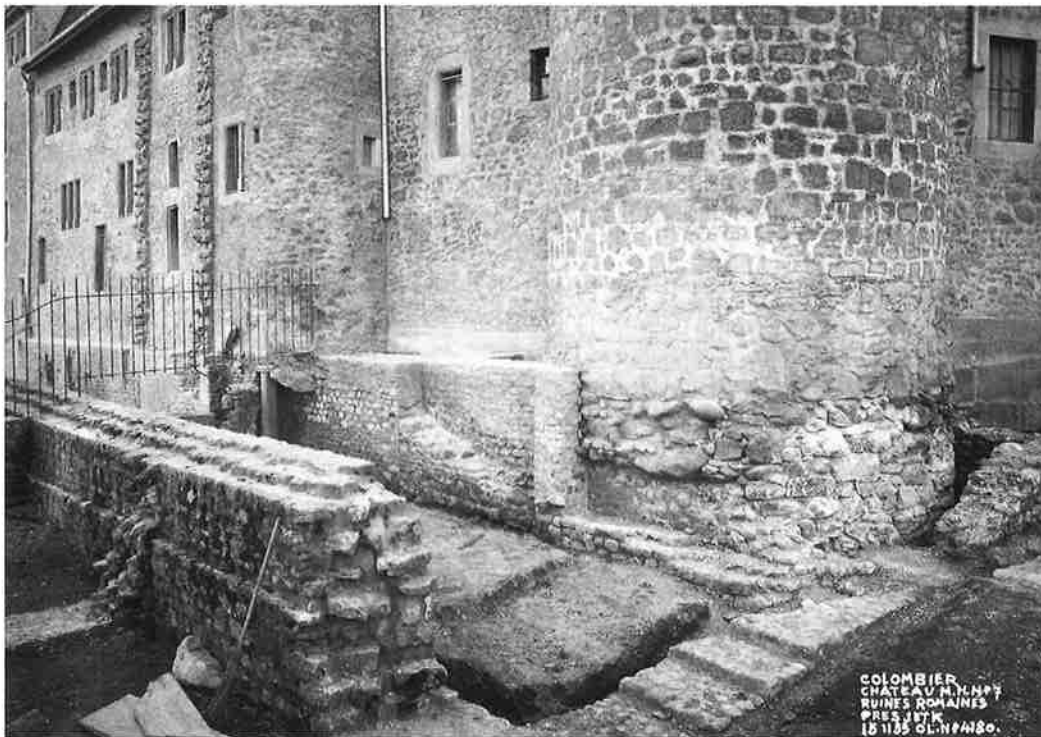
Fig. 5 Maçonneries superposées des façades orientales de la villa et du château de Colombier. Photo Archives du Service de la protection des monuments et des sites, Neuchâtel 1993.
