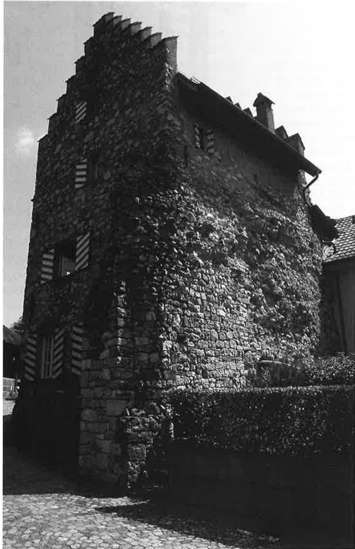
Abb. 2 Ansicht der in der mittelalterlichen Burg wiederverwendeten römischen Mauerteile des spätromischen Kastells Brugg AG-Altenburg. Photo H. Windler, Reinach.
