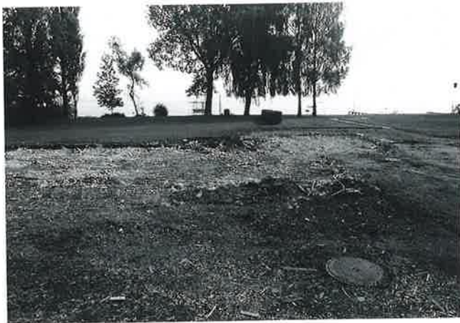
Abb. 30. Hünenberg-Chämleten, Strandbad, Grabung 1993. Nach Abriss der 1963 erstellten Garderobengebäude. Photo KAZ.
