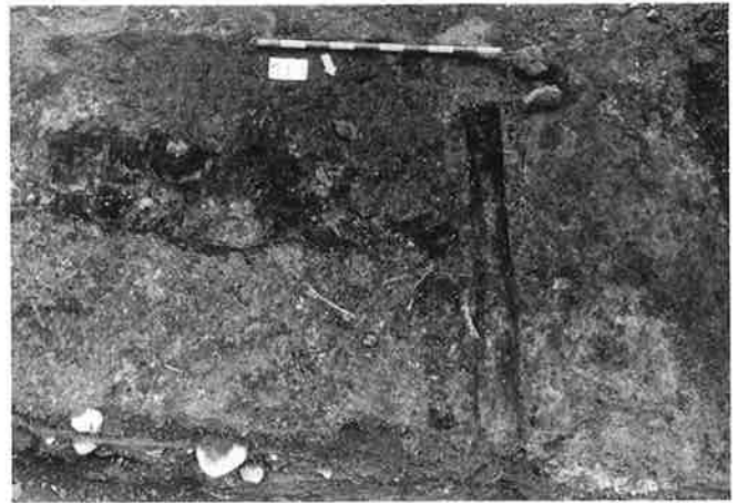
Abb.10. Holzbauperiode II. Räume D und C mit Zwischenwand und Holztüre zu Raum G. Aufnahme nach Süden.
