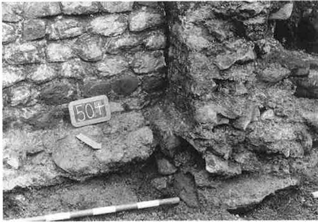
Abb. 14. Steinbauperiode I.1. Anschluss der Mauer von Haus III zwischen den Räumen P und R an die verputzte östliche Aussenmauer von Haus II. Aufnahme nach Süden.
