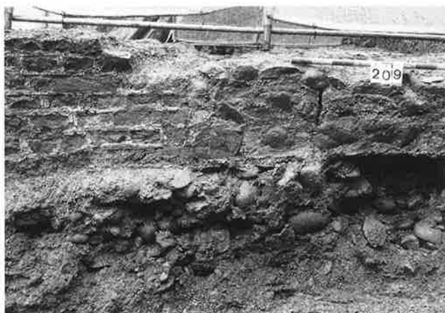
Abb. 21. Steinbauperiode I.1, westliche Aussenmauer von Haus II. Bau- fugen beim Hauptteil (links) und mit Raum K (rechts). Aufnahme nach Osten.
