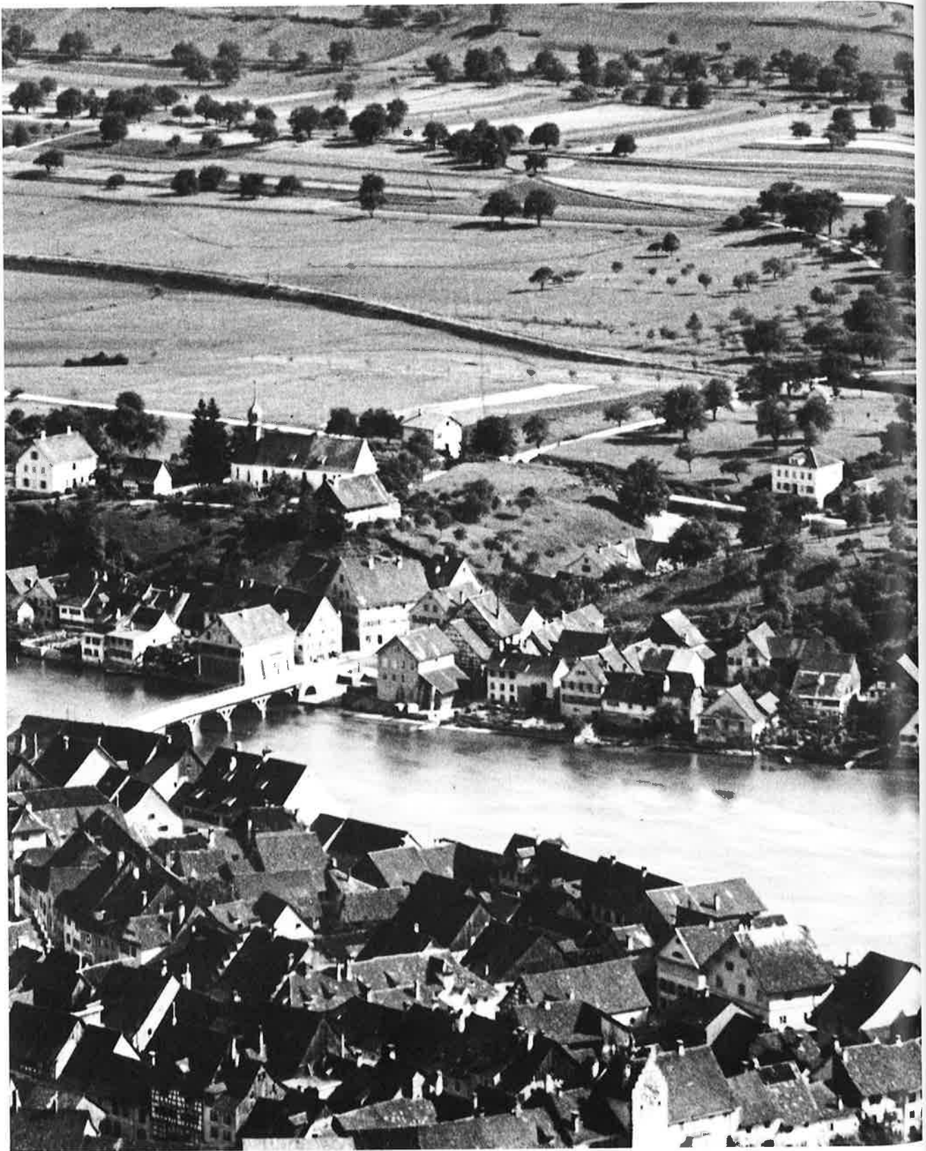
Abb. 48: Stein am Rhein. Kastell Burg. Ansicht des Kastelhügels zu Beginn der Ausgrabungen (nach 1895, vor 1900).
