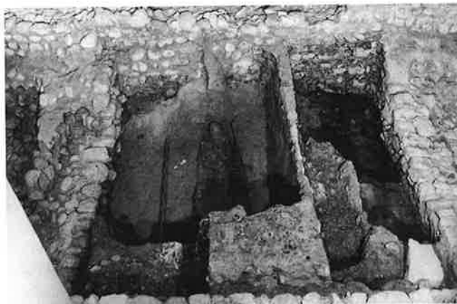
Abb. 198: Stein am Rhein. Stadtkirche 1990. Fundamentreste des quadratischen Westturms in der Vorhalle. Blick nach Westen.
