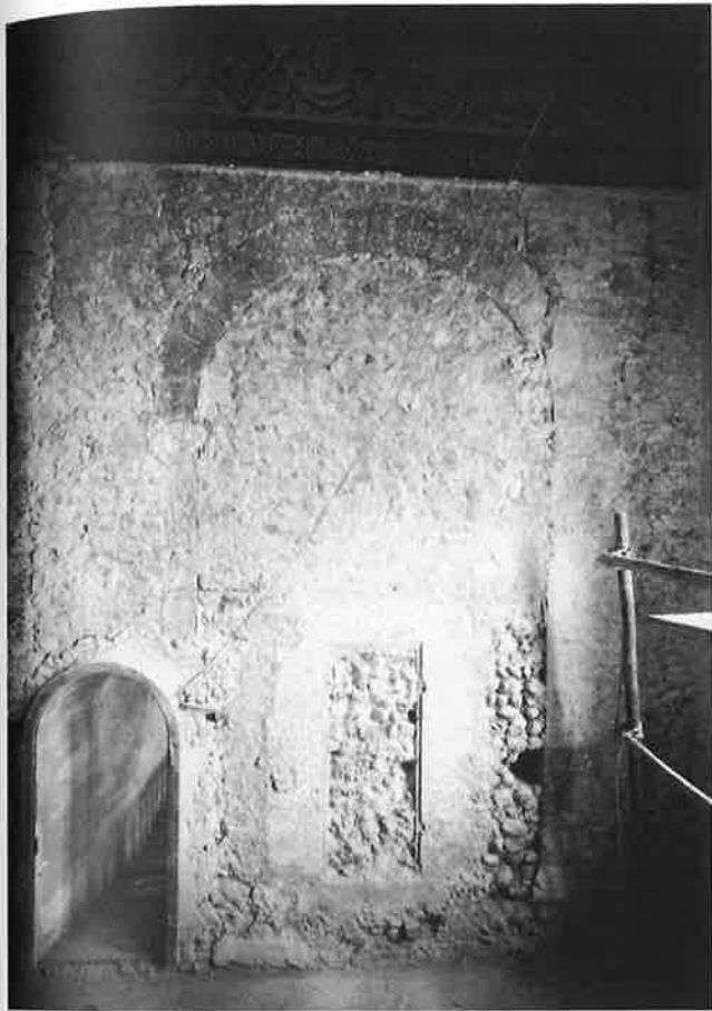
Abb. 209: Stein am Rhein. Stadtkirche. Renovation 1931. Bogenstellung in der Nordfassade des Südturmes gegen die ursprüngliche Empore. Am linken Bildrand die Wundvermauerung mit Backsteinen der ehemaligen Vorhallenwand.
