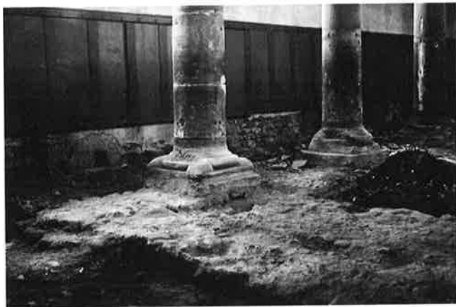
Abb. 197: Stein am Rhein. Stadtkirche. Renovation 1931. Säulen der südl. Arkadenreihe auf älterem (?) Mauerfundament, rechts das Treppenfundament zum ehemaligen Mönchschor.
