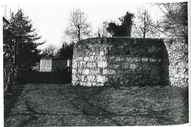
Abb. 79: Stein am Rhein. Kastell Burg. Ansicht der Südseite. Kalksteine wurden 1903 an Stelle der Bollensteine vermauert.
