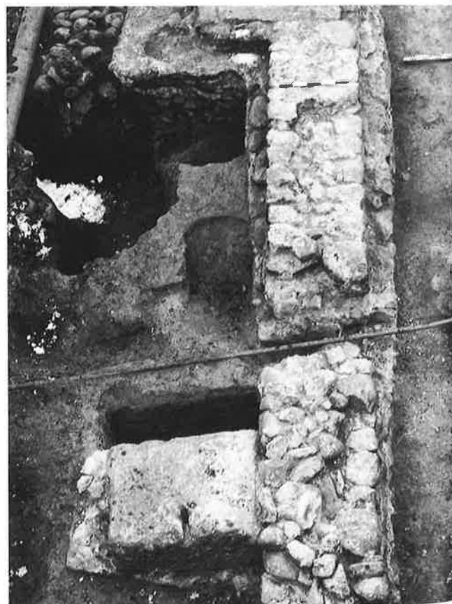
Abb. 61: Stein am Rhein. Kastell Burg. Pfarrhaus-Vorplatz 1978. Nordwand mit Stützpfilern. Blick gegen Westen.
