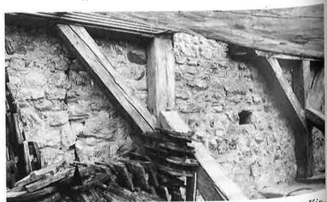
Abb. 204: Stein am Rhein. Stadtkirche. Baufrage zwischen Kirchenschiff und Chor im Dachraum über dem südl. Seitenschiff.
