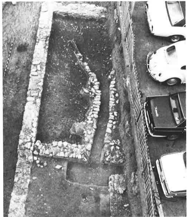
Abb. 14. Gebäude 6, Raum E1 von Norden. Gemauerte Kanalheizung mit Praefurnium nördlich von Mr.2. Unten Raum D mit östlichstem der vier Sockel.
