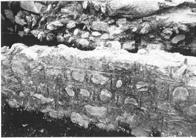
Abb. 64. Gebäude 8, Mr.2 mit Fugenstrich. Von Osten.
