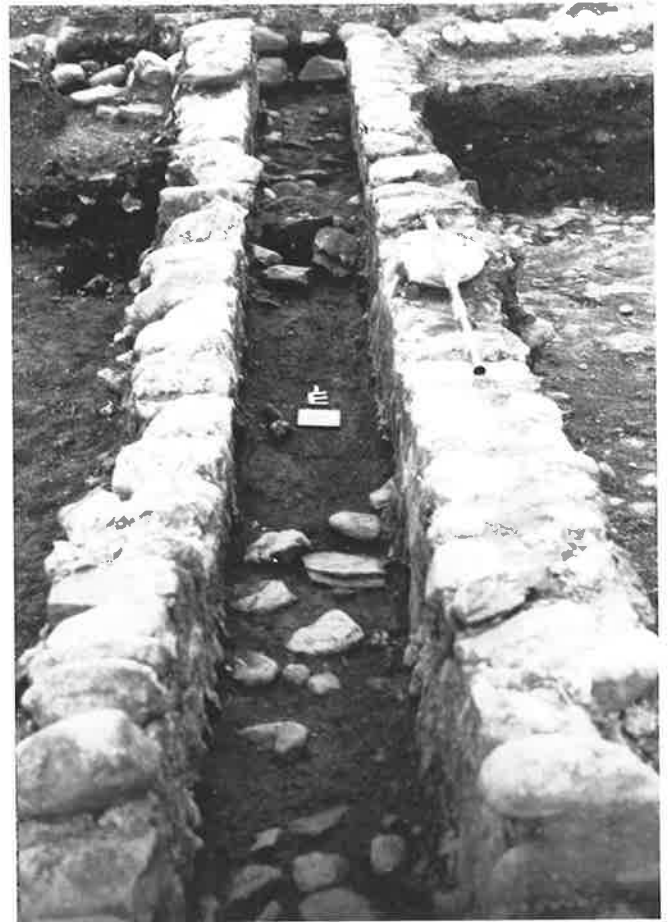
Abb. 34. Gebäude 7. Gemauerter Kanal in Raum J. Von Westen.
