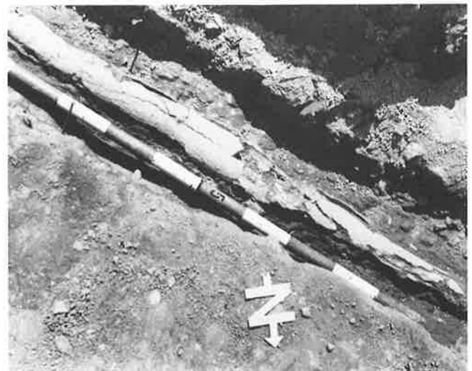
Abb. 42. Kalksinterungen der Leitung a.
