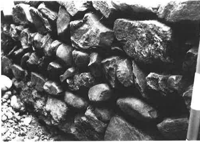
Abb. 69. Gebäude 9, Nordhaupt von Mr.21.
