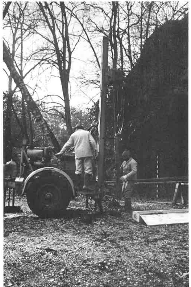
Abb. 2: Bohrgerät in Betrieb vor dem östlichen Höhleneingang (Foto J. Sedlmeier).
