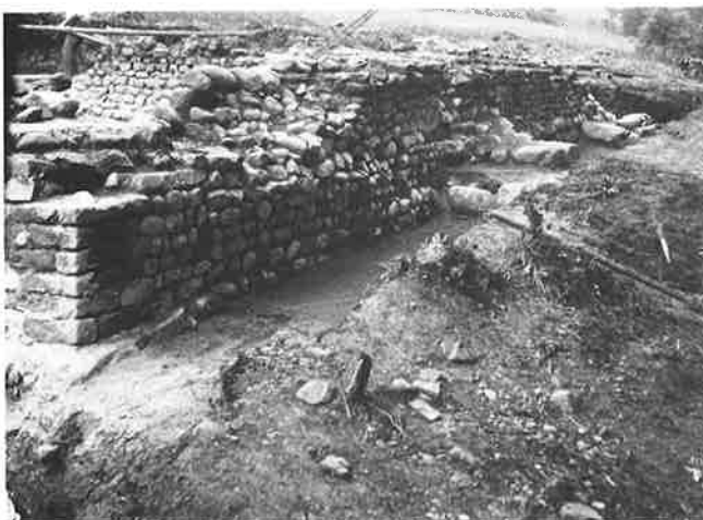
Abb. 23 Stutheim/Hüttwilen. Blick von Südwest auf die Südwestecke des Westrisalites.
