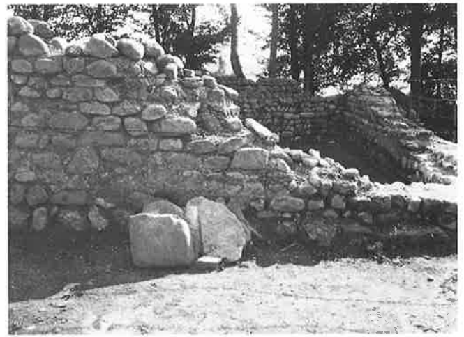
Abb. 18 Stutheien/Hüttwilten. Blick von Norden an die Südmauer von Raum I und in Raum IV.
