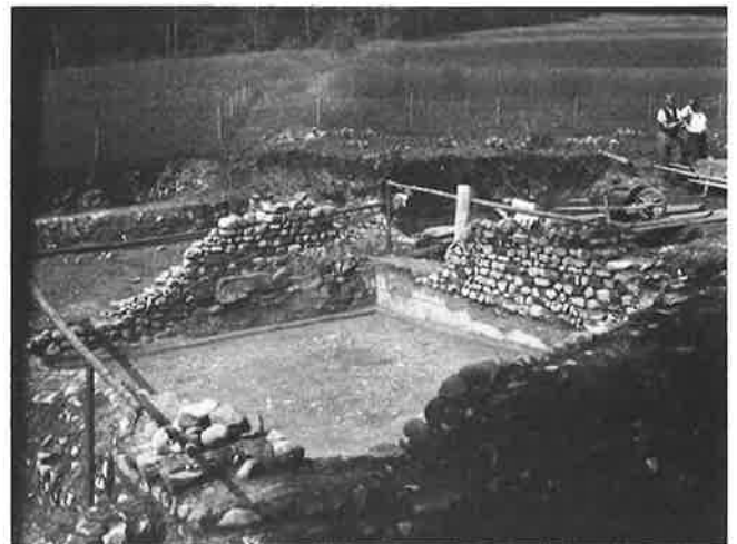
Abb. 20 Stutheien/Hüttwilen. Blick von Südwesten in Raum IV. Gut erkennbar sind der Mörtelboden, der Wandverputz und die Viertelstableiste, welche den Boden vom Verputz trennt.
