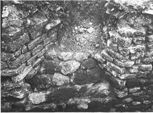
Abb. 27 Stutheien/Hüttwilen. Blick von Norden auf die Innenseite eines der Kellerfenster.
