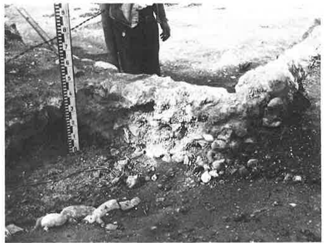
Abb. 19 Stutheien/Hüttwilen. Blick von Südosten auf die zerstörte Mauerecke J1K1L1 von Raum I.
