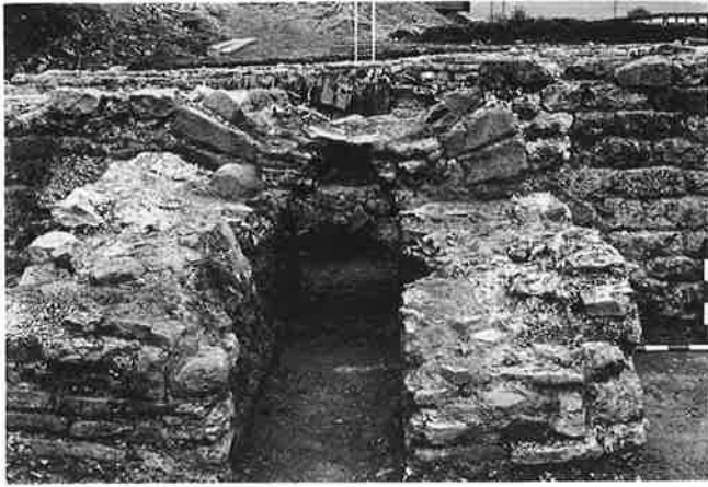
Abb. 33 Präfurnium R9. Das Gewölbe aus Sandsteinen ist nachträglich in die Mauer eingesetzt und innen mit Ziegeln verkleidet worden.
