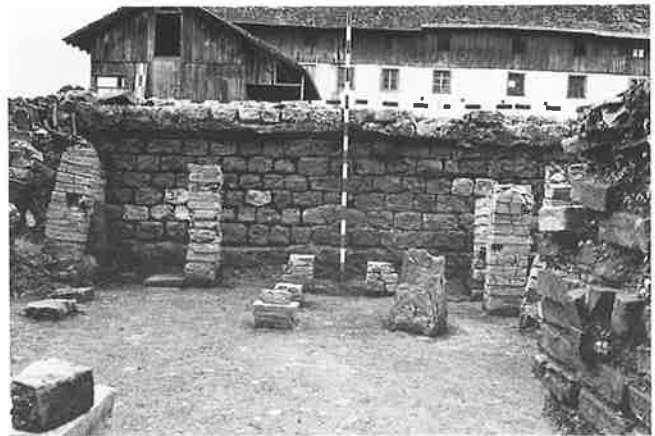
Abb. 35 R8a: Blick Richtung Ost gegen die Westwand des Frigidarium. Gut sichtbar ist, wie die obersten Steine auf der Höhe des ehemaligen Gehbodens vorkragen. Rechts vom Jalon ein Pfeiler aus Sandstein.
