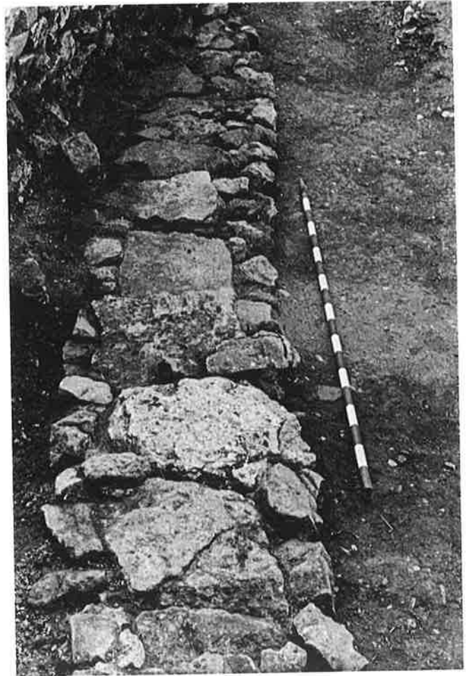
Abb. 51 Abwasserkanal in R9
