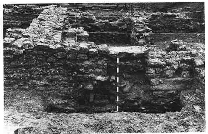
Abb. 12 Tür zu Gang R13. Deutlich sichtbar sind die übereinanderliegenden Schwellen.
