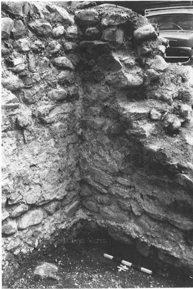
Abb. 23. Mauerecke II/IV im Verband, mit Resten von Verputz.
