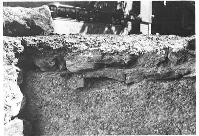
Abb. 16. Raum D, Hypokaustraum, Mr. XVII a mit Mörtelverputz.
