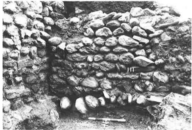
Abb. 24. Mauerecke III/XIII, III stumpf an XIII angebaut.
