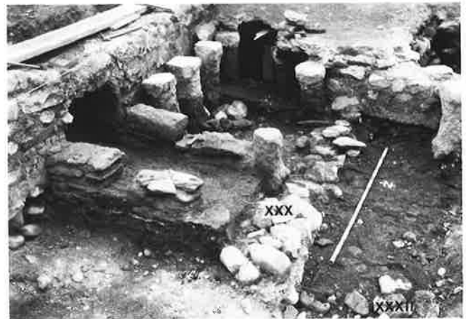
Abb. 30. Der Hypokaustraum D mit dem Feuerkanal links; davor die beiden im Verband stehenden, bis auf die unterste Steinlage abgerissenen Mr. XXX/XXXII.
