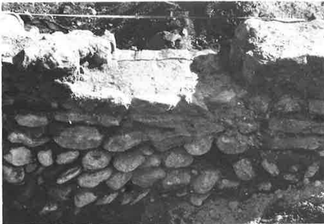
Abb. 14. Südhaupt von Mr. XIX mit Eingang zu Raum D.
