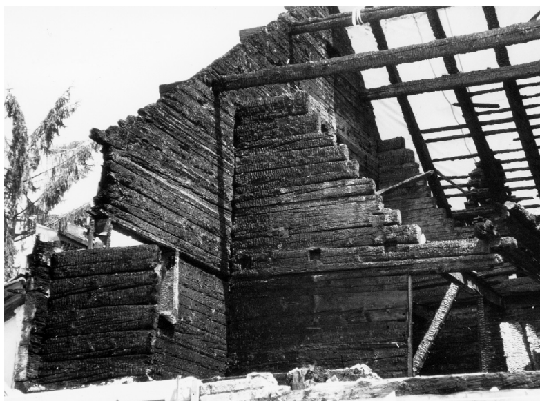
Abb. 13 Blockbau im Herrlisberg als Brandruine gegen Norden. Sichtbar sind die mächtigen, abgestuften Vorstösse ins Hausinnere zur Sicherung der westlichen Giebelwand. Foto Denkmalpflege des Kantons Zürich, Dübendorf.
