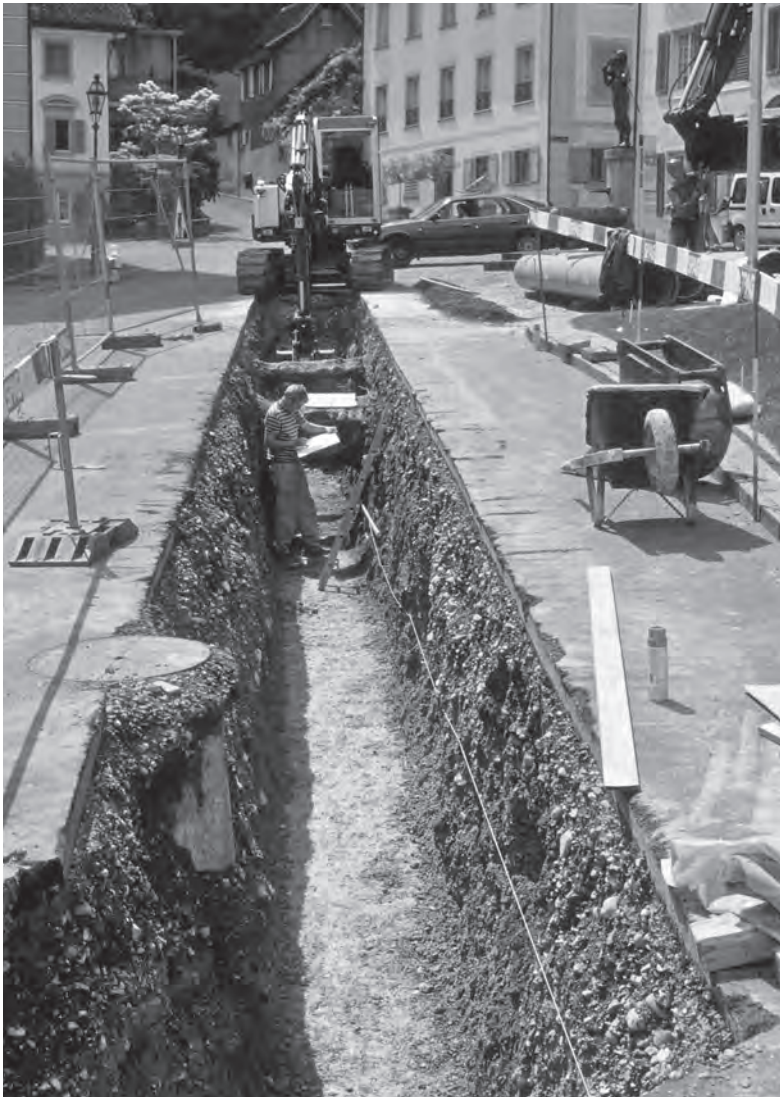
Abb. 32 ■ Stans Dorfplatz 2003. Graben G71 zu Beginn der Dokumentationsarbeiten. Von Nordwesten.
