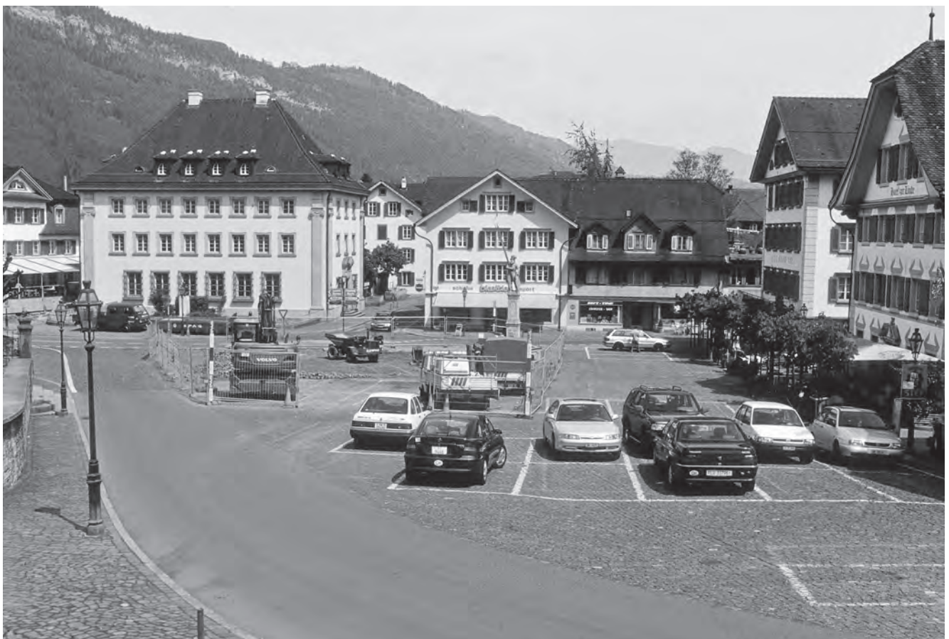
Abb. 1 Stans Dorfplatz 2003. Der Dorfplatz am 30. April 2003, bei Beginn der Bauarbeiten. Von Südwesten.
