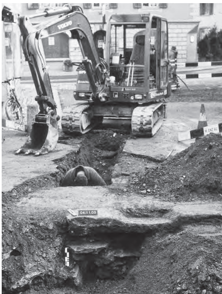
Abb. 16 ■ Stans Spittelgasse 2003. Rückseite der südwestlichen Wange des Dorfbachs (Kanal 2) mit eingehauenen seitlichem Wassereinlass. Von Südwesten.
