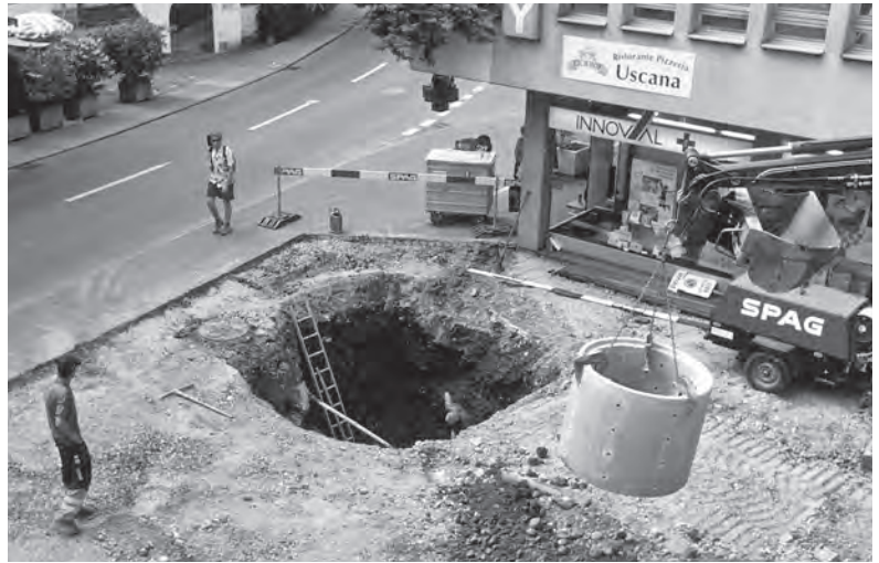
Abb. 3 ■ Stans Dorfplatz 2003. Bau eines Sickerschachtes vor der Liegenschaft Alter Postplatz 2. Von Südosten.
