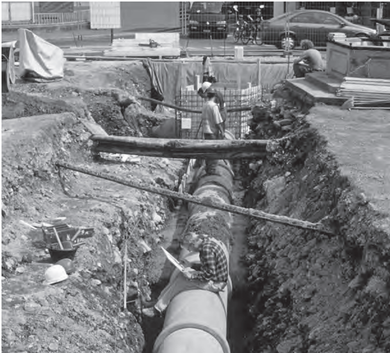
Abb. 5 Stans Dorfplatz 2003. Profilaufnahme im Graben G1. Wegen der Einsturzgefahr vor dem Verlegen der Rohrleitung muss die linke Grabenflanke aus Sicherheitsgründen gestuft ausgehoben werden. Von S.
