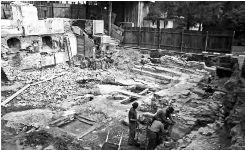
Abb. 6. Baden, Bäderquartier. Baugrube für die Trinkhalle 1968. Die heutige Nordfassade des benachbarten „Schweizerhofs“ steht auf römischem Mauerwerk. Foto Kantonsarchäologie Aargau.
