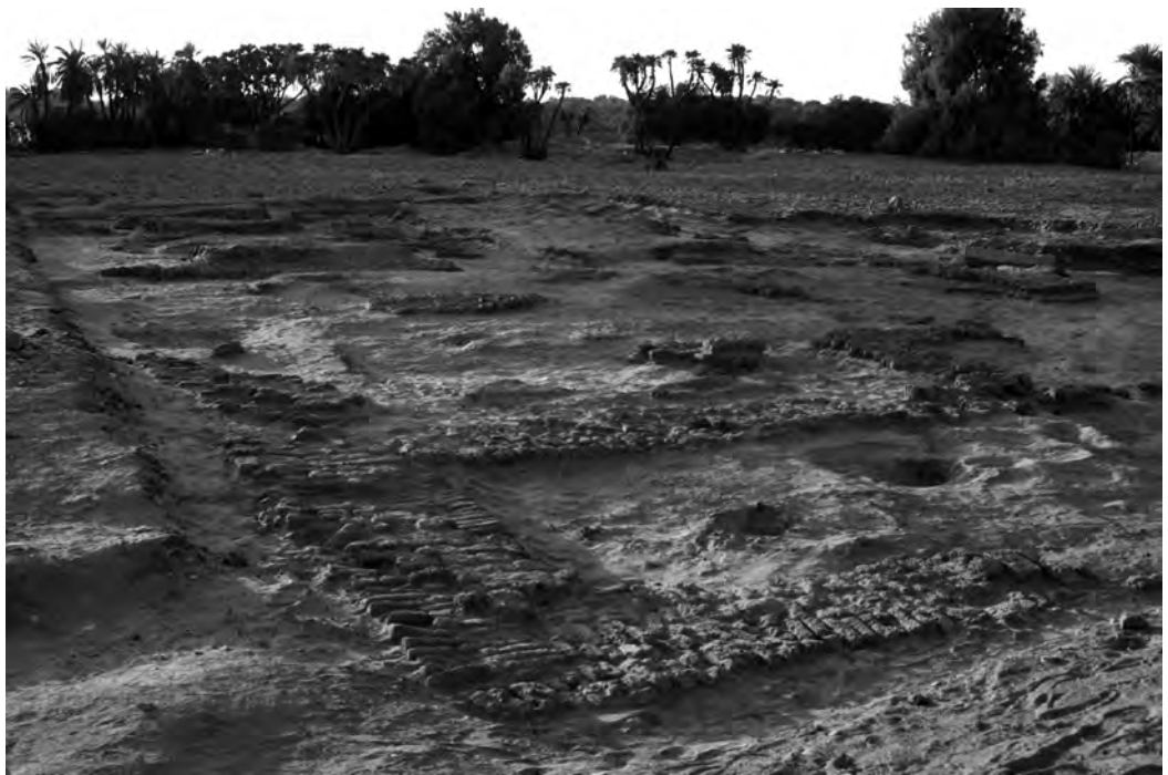
Abb. 3 Nag al-Hagar, Schlammziegelfundamente der Südostecke und der Innenmauern der Mannschaftsunterkunft im Südostbereich, von Osten. Foto R. Franke 2009.
