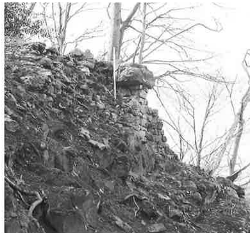
Abb. 45 Loppburg 2001. Mauer M1. Letztes oberflächlich gut sichtbares pilzförmiges Mauerstück vor Beginn der Untersuchungen 2001. Von Südosten.
