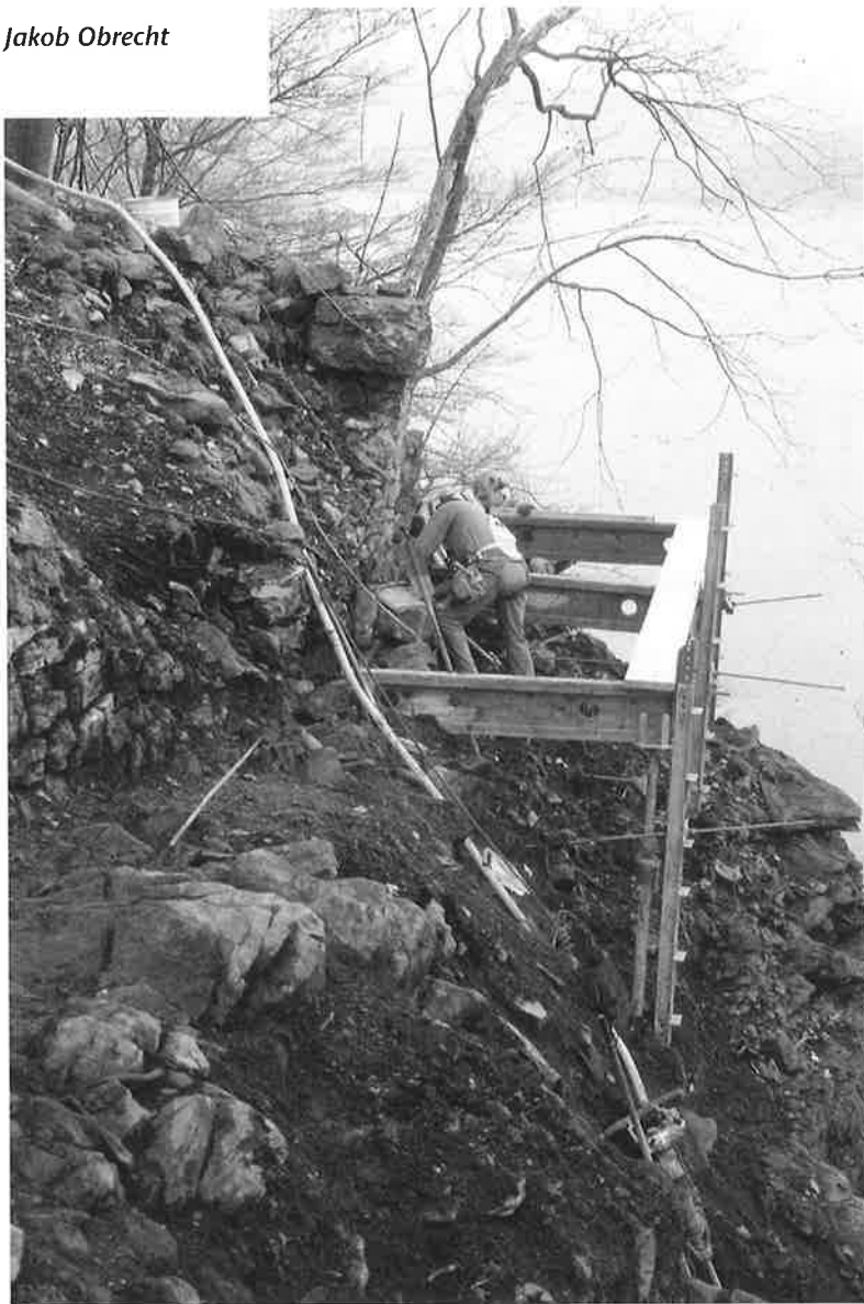
Abb. 81 Loppburg 2001. Bau eines soliden, im Fels verankerten Gerüstes vor der Mauer M1. Von Südosten.
