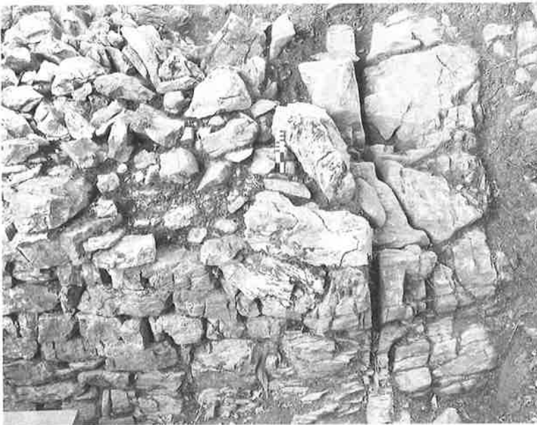
Abb. 48 Loppburg 2001. Mauer M2. Das westliche Ende der Mauer geht in den unteren Lagen nahtlos in den anstehenden zerklüfteten Fels über. Von Nordnordwesten.
