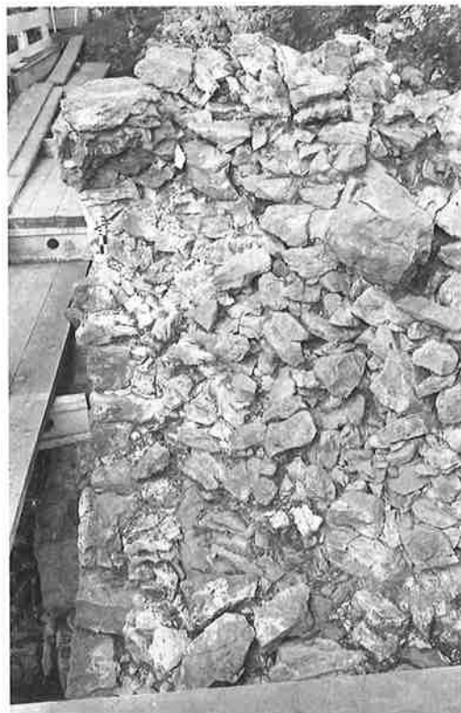
Abb. 40 Loppburg 2001. Mauer M1. Mauermantel und Mauerkern südlich der Ecke M1/M2. Beach- tenswert ist die geringe Tiefe der Vermörtelung hinter dem Mantel- mauerwerk. Von Nord- nordwesten.
