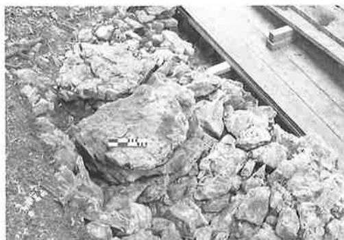
Abb. 49 Loppburg 2001. Mauer M1. Frisch freigelegter trocken aufgeschichteter Mauerkern. Die beiden grossen plattigen Steine erinnern an die Sockel- steine I-IV in der Zone Z1 und an die Blöcke auf dem Wallabschnitt in F42. Von Süden.
