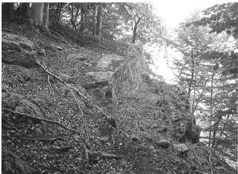
Abb. 83 Loppburg 2001. Gesicherte und konservierte Mauer M1 im Jahr 2007. Von Süd-osten.
