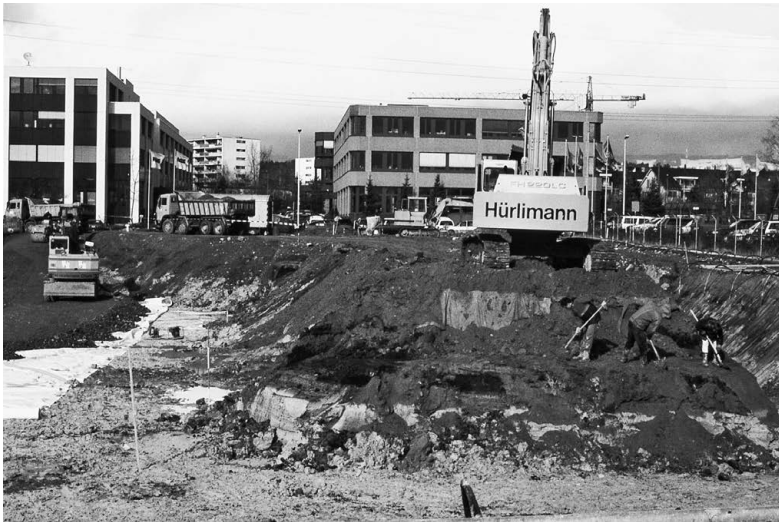
Abb. 20 Steinhausen-Sennweid, Rettungsgrabung Cosmetochem 1995. Arbeit vor der Baggerschaukel.
