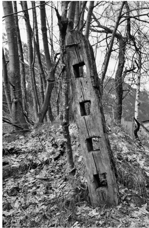
Abb. 176 Leventina (Tessin), Strada alta. Zaunpfahl aus Kastanienholz mit vierkantigen Löchern für die Einlage von Horizontalstangen.
