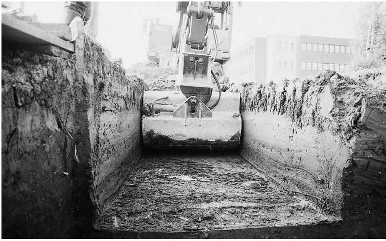
Abb. 8 Steinhausen-Chollerpark. Ein Sondierschnitt wird geöffnet: Die Baggerschaufel entfernt zügig die jüngeren Deckschichten über der obersten holzführenden Fundschicht.
