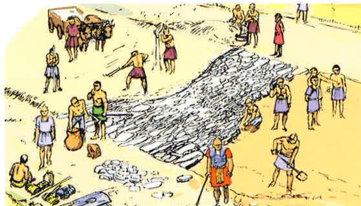
Des légionnaires romains construisent une route dans la région de Porrentruy, au 1 er siècle ap. J.-C. Dessin T. Yilmaz, Office de patrimoine historique du Canton de Jura.
