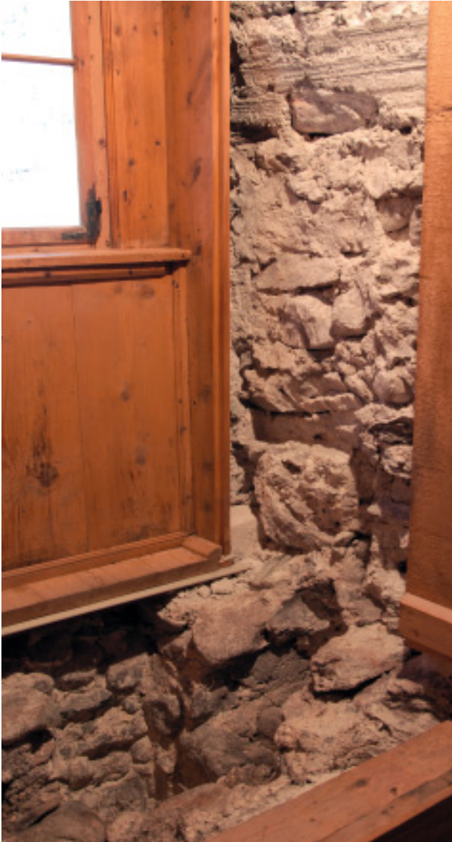
Abb. 20. Müstair, Kloster St. Johann, Plantaturm. Ehemalige Abortnische Kat. 3.16, heutige Fensteransicht im 2. Obergeschoss, gegen Nordosten. Foto AD GR, Bauhütte Müstair.
