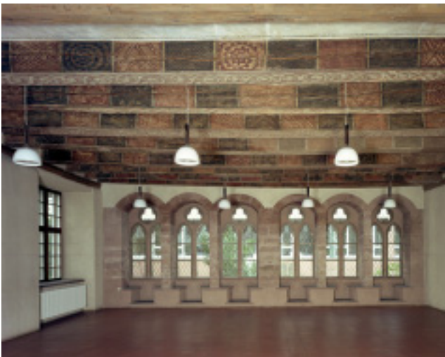
Abb. 15. Basel, Nadelberg 6, «Schönes Haus». Blick auf den Festsaal im 1. Obergeschoss (Rückseite) mit der gleichen sechsachsigen gotischen Fensterfront wie an der Vorderseite (kurz nach 1270/vor 1280). Die Quadermalerei an den Balken gehört zur ursprünglichen Ausstattung des Herrschaftssitzes von 1270. Sie fasst die mit verputzten Brettern belegten Geschossbalken mit in einzelne Quader unterteilten Feldern, die mit ihren Motiven an Marmorinkrustationen der Opus sectile-Ornamentik erinnern. Geometrische und schneckenartig gerollte Dekorbänder sowie Fabeltiere schmücken die Felder in wechselnden Farben. Foto Basler Denkmalpflege.
