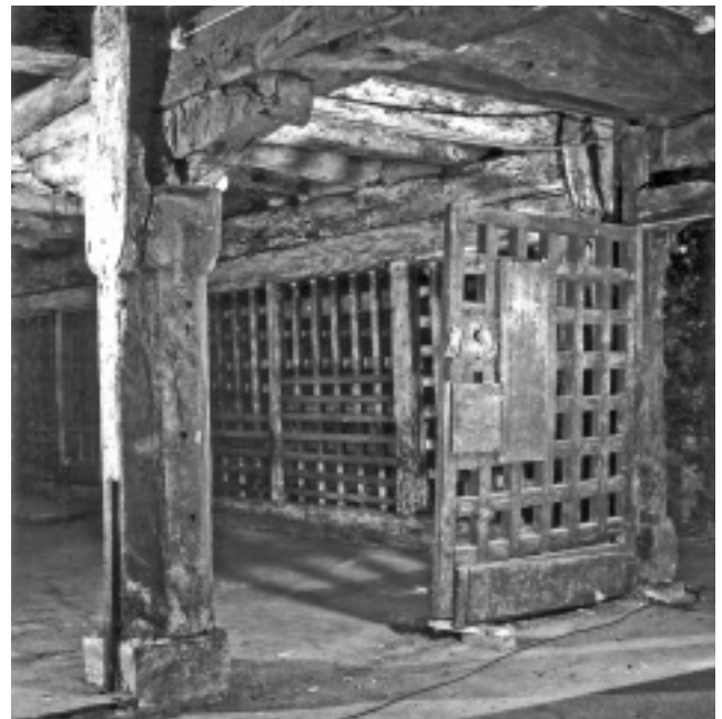
Abb. 28. Basel, Peterskirchplatz 1, «Zum Grossen Keller». Blick in das unterste Kellergeschos mit originalen Pfeilern und Decken in Richtung Talhang, mit spätmittelalterlicher gitterartiger Raumunterteilung (2. Hälfte 13. Jh.). Foto Basler Denkmalpflege.
