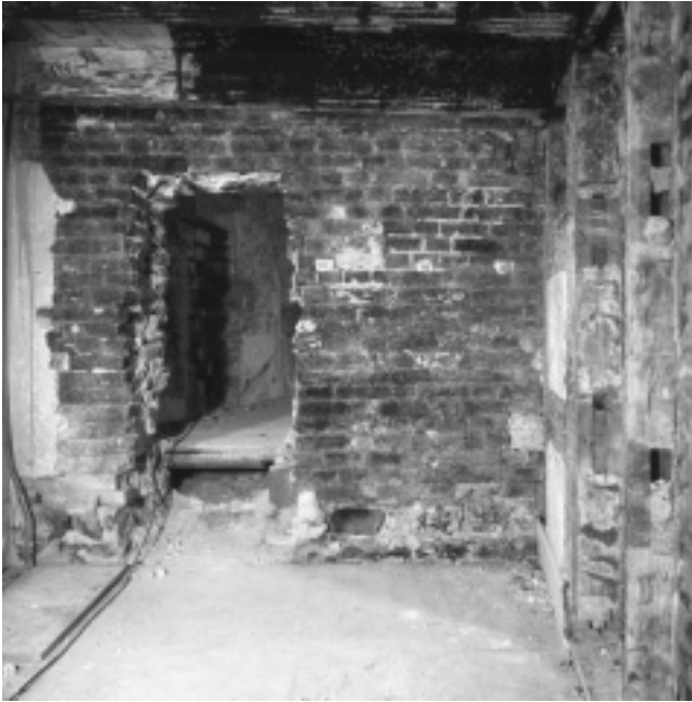
Abb. 11. Luzern LU, Bahnhofstrasse 12-18. Mauerschalen aus Backstein ab dem dritten Obergeschoss am Kernbau des Gebäudekomplexes. Um 1300 (bautypologisch). Foto IBID Altbau AG/KA LU.
