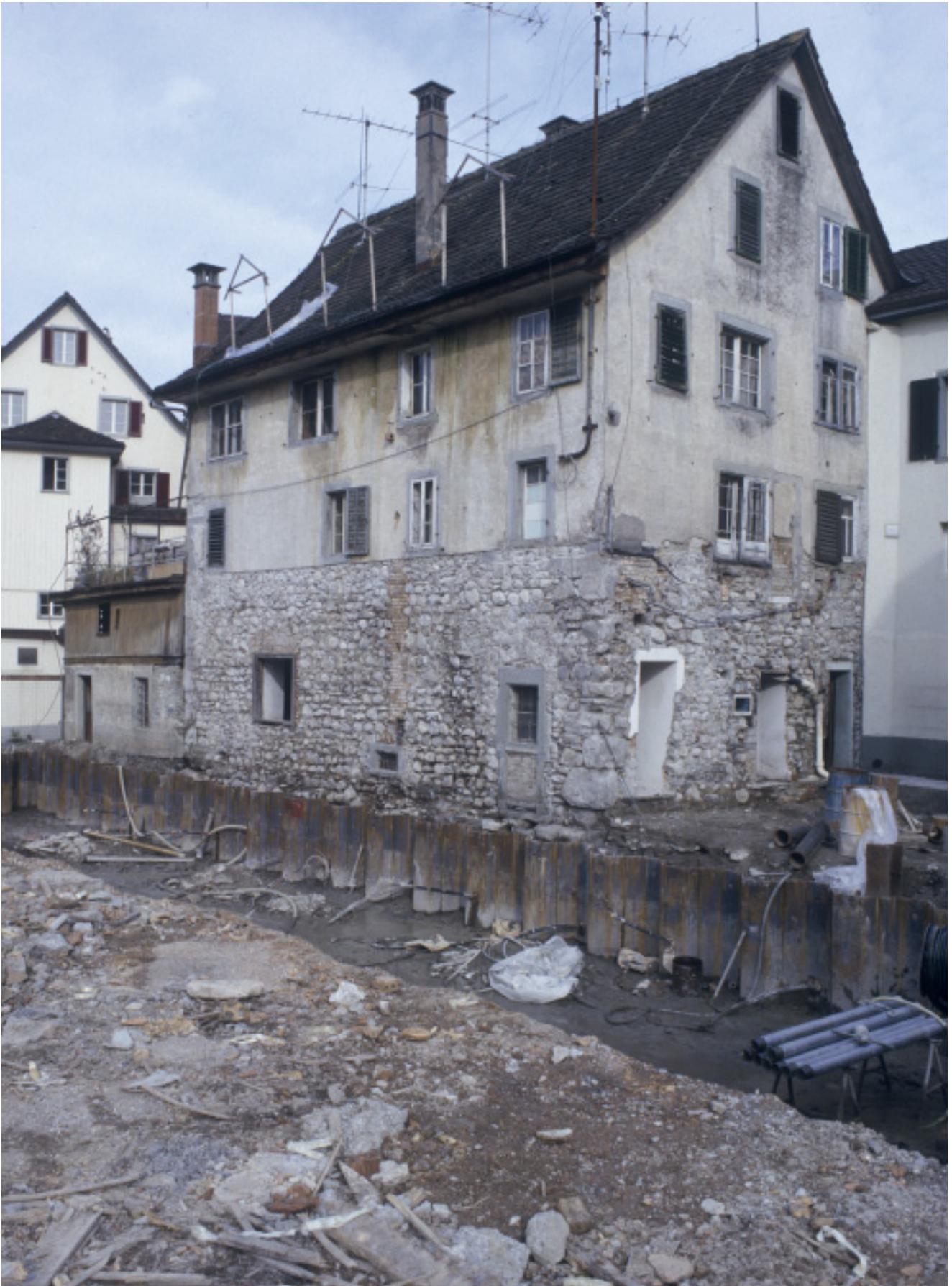
Abb. 11. Richterswil ZH, Poststrasse 8. «Weiherhaus», Sockelgeschoss mit Schlitzfenstern (auf der Rückseite) und Oculus 13./14. Jh. (Datierungsbasis Typologie). KA ZH.
