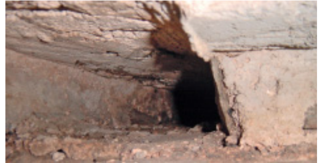
Abb. 15. Müstair, Klosterkirche. Der höhere Ankerbalken Kat. 1.10 in der Kirchenost-mauer ist mit der von rechts kommenden Mauerlatte Kat. 1.9 in der Kirchennord-mauer überblattet. Aufnahme in der Nordostecke gegen Südosten. Foto AD GR, Bauhütte Müstair.
