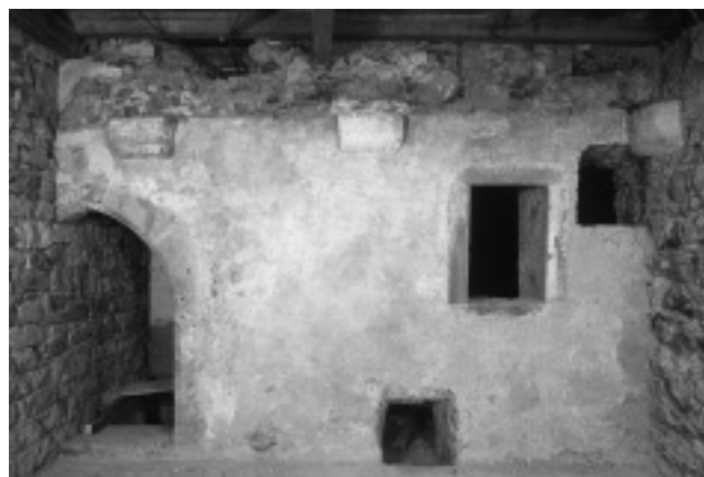
Abb. 31. Basel, Nadelberg 12, ehem. «Griebenhof». Blick in bzw. auf den originalen Keller. Der eingeschossige Westkeller ist im Bau von 1855 im Prinzip erhalten, wenn auch durch neue Mauern verdeckt. Dahinter der im Kernbau erhaltene Doppelkeller (unteres Geschoss zugeschüttet). Situation s. Abb. 29. Foto ABBS.
