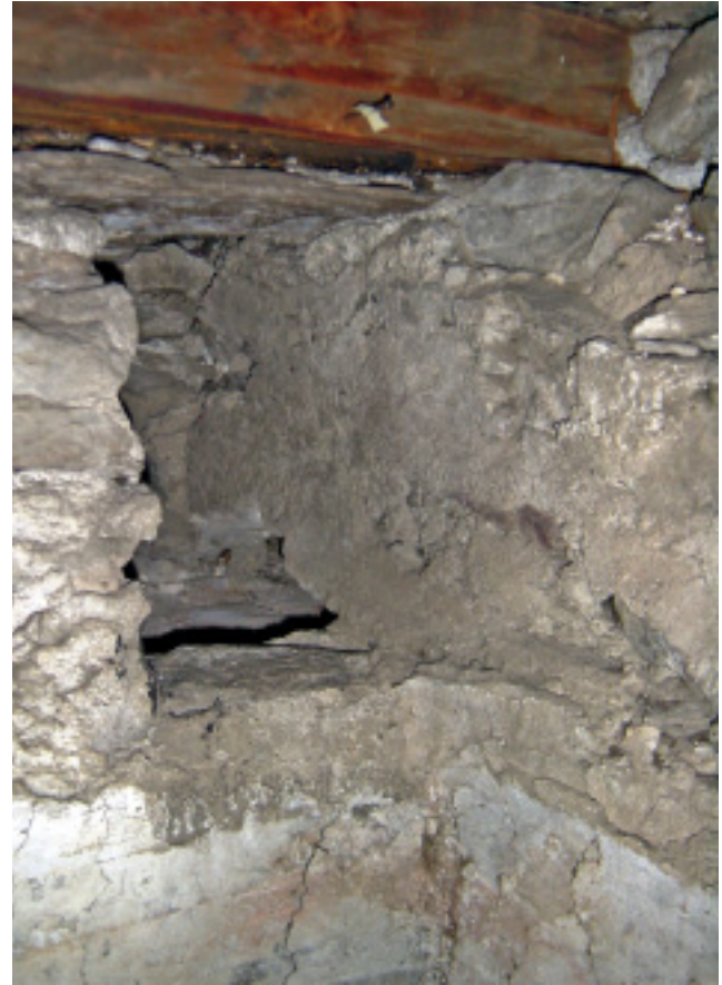
Abb. 7. Müstair, Klosterkirche, Dachraum. Negativ des östlichen Deckenbalkens Kat. 1.11 und Überblattung mit der Mauerlatte Kat. 1.9 (Schattenwurf im Negativ). Der grobe Erstverputz des Innenraums wurde gegen den Deckenbalken gestrichen, der feine Intonaco der Wandmalereien rechnete bereits mit der Verschalung der Deckenuntersicht. Foto AD GR, Bauhütte Müstair.
