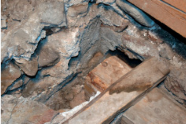
Abb. 16. Müstair, Kloster St. Johann, Heiligkreuzkapelle, Dachraum. Negative der Mauerlatte Kat. 2.8 und der Deckenbalken Kat. 2.9 in der Südwestecke hinter den Deckenhölzern von 1520, gegen Südwesten. Foto AD GR, Bauhütte Müstair.
