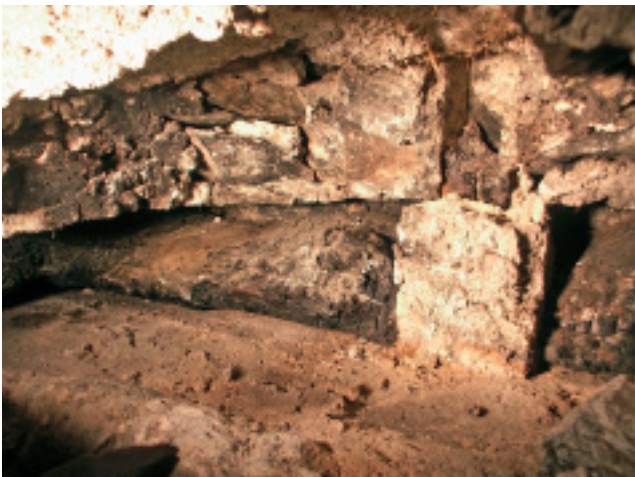
Abb. 3. Müstair, Klosterkirche. Verkohlte Mauerlatte Kat. 1.15 nahe der Spitze des östlichen Kirchengiebels mit Mörtel in der Ausnehmung für ein vertikales Vierkantholz, das wir als möglichen Vermessungsposten für die Giebelspitze interpretieren. Foto AD GR, Bauhütte Müstair.
