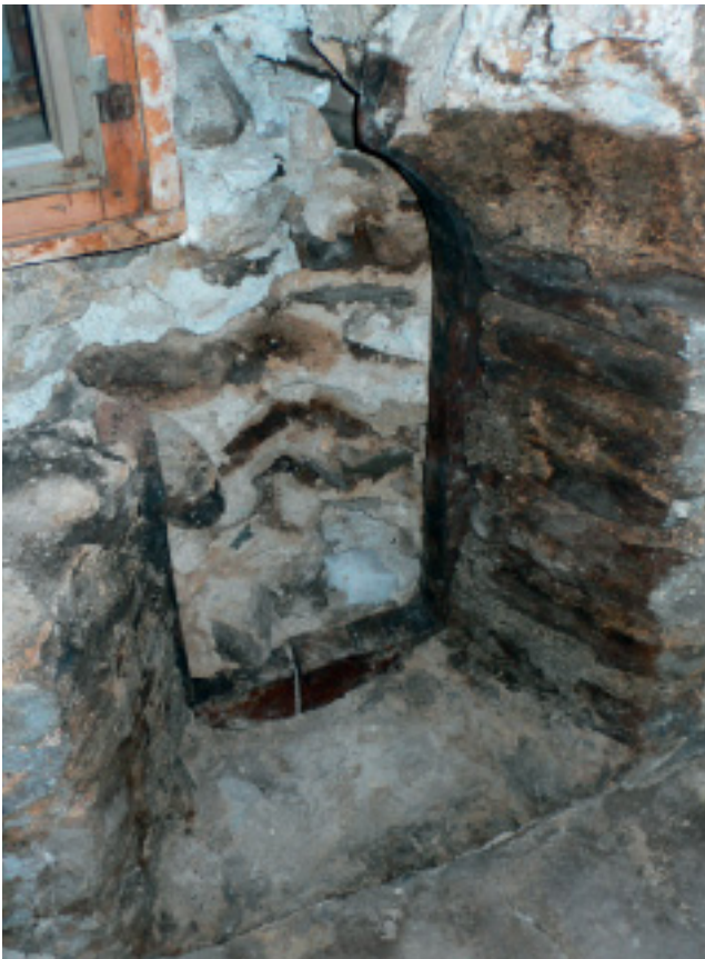
Abb. 10.11. Müstair, Kloster St. Johann, Westtrakt/Norpertrakt. Rundbogenfenster Kat. 4.16 im Mittelurm der Bischofsresidenz von 1035 über dem westlichen Eingangportal, Rahmen mit (ausgebrochenem) Kreuzstock aus einer einzigen Bohle gehauen. Befund und Rekonstruktionszeichnung. Foto/Zeichnung AD GR, Bauhütte Müstair.
