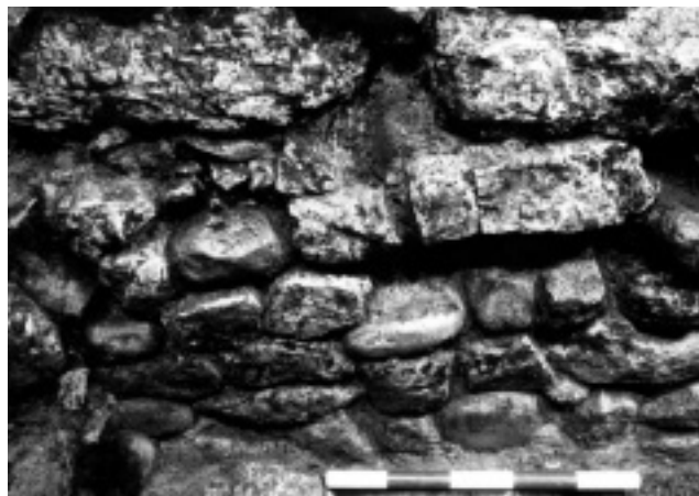
Abb. 4. Solothurn. Hauptgasse 48–50. Römische Vicusmauer M17 als Fundament der Brandmauer M111. Foto KA SO.
