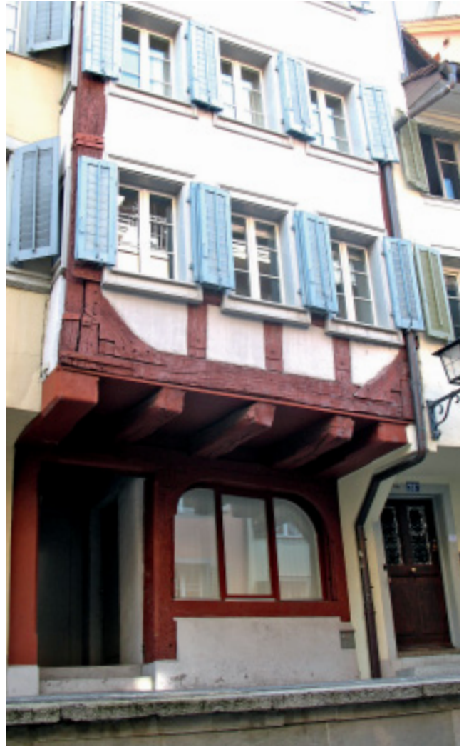
Abb. 4. Neue städtische Hausbautypen: nach dem Stadtbrand von 1370/71 entstandenes Holzhaus an der Obergasse in Zug. Aufnahme G. Descoedres.
