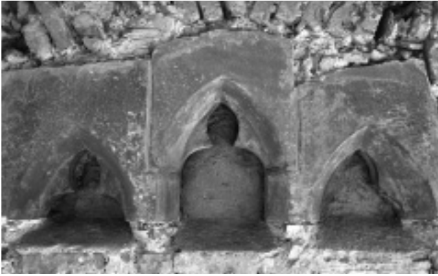
Abb. 11. Basel, Unterer Rheinweg 26, «Kleines Klingental». Sturz des dreiteiligen originalen Masswerkfensters im Obergeschoss, das von einer ebenfalls zum Originalbestand gehörenden Backsteinausrollung entlastet wird; vor/um 1274 (s. auch Abb. 10). Foto Basler Denkmalpflege.
