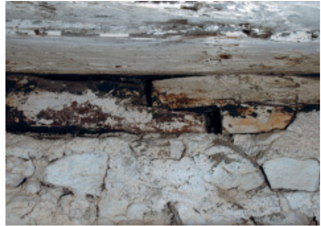
Abb. 5. Müstair, Kloster St. Johann, Heiligkreuzkapelle, Untergeschoss. Mauerlatten Kat. 2.2 der Südapsis mit Überblattung und Holznagel. Foto AD GR, Bauhütte Müstair.
