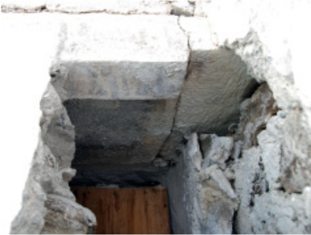
Abb. 8. Müstair, Kloster St. Johann, Heiligkreuzkapelle. Originale, karolingische Türe aus Marmor in der Westflanke der Nordapsis. Foto AD GR, Bauhütte Müstair.
