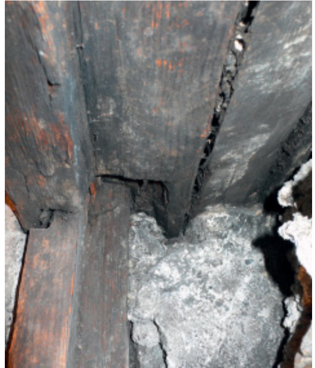
Abb. 13. Müstair, Kloster St. Johann, Westtrakt/Norpertrakt. Rechteckiges Nordfenster Kat. 4.11 im nördlichen Obergeschosssaal. Detail der Stockverbindungen und des inneren Falzes. Foto AD GR, Bauhütte Müstair.
