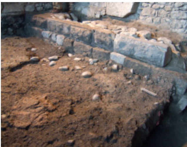
Abb. 6. Zürich, Limmatquai 82. Die aus Bossenquadern gefügte Limmatufermauer des 12. Jh. Blick nach Nordosten. Foto Stadtarchäologie Zürich.
