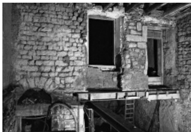
Abb. 22. Basel, Schneidergasse 12. Wohnturm während den Untersuchungen mit Eingangsportal des Korridorganges (unten links) und Hocheingang (oben rechts), der sich als Türe noch bis ins 20. Jh. halten konnte (13. Jh.; s. auch Abb. 21). Foto ABBS.
