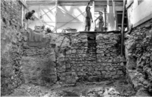
Abb. 33. Basel, Schützenmattstrasse 11. Blick auf den freigelegten Keller (Fassadenfundament) mit einem originalen Fensterschacht (Putz abgespitzt; Kellerwand rechts teilweise bereits modern abgebrochen; 13. Jh.). Situation s. Abb. 32. Foto ABBS.
