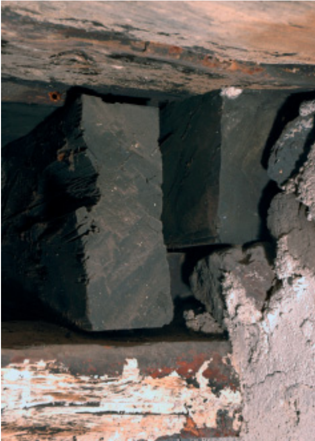
Abb. 6. Müstair, Kloster St. Johann, Heiligkreuzkapelle, Untergeschoss. Stirn eines Deckenbalkens Kat. 2.3 des Kapellenschiffs, auf der Mauerlatte Kat. 2.2 am Eingang zur Südapsis aufliegend, rechts ein Deckenbalken der erhöhten Ostapsis. Blick von der Südapsis gegen Nordosten. Foto AD GR, Bauhütte Müstair.
