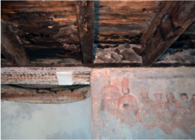
Abb. 4. Müstair, Kloster St. Johann, Heiligkreuzkapelle, Untergeschoss. Die Mauerlatten Kat. 2.2 auf der Südmauer überbrücken den Zwischenraum zur Südapsis, darüber liegen Deckenbalken und Bodenbohlen, auf dem Apsisrund die gerundeten Mauerlatten mit Überblattung (s. auch Abb. 5). Foto AD GR, Bauhütte Müstair.
