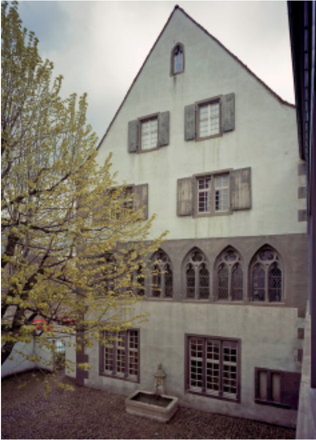
Abb. 14. Basel, Nadelberg 6, «Schönes Haus». Blick auf die Vorderfassade mit den originalen gotischen Masswerkfenstern im Obergeschoss (kurz nach 1270/vor 1280). Abgesehen von einem kleinen Rest unten rechts sind alle anderen Fenster aus jüngerer Zeit. Foto Basler Denkmalpflege.
