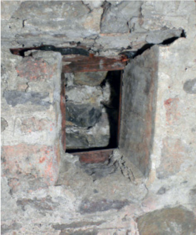
Abb. 12. Müstair, Kloster St. Johann, Westtrakt/Norpertrakt. Rechteckfenster Kat. 4.11 im nördlichen Obergeschosssaal der Bischofsresidenz von 1035. Übersicht von aussen an die ehemalige Nordfassade. Foto AD GR, Bauhütte Müstair.
