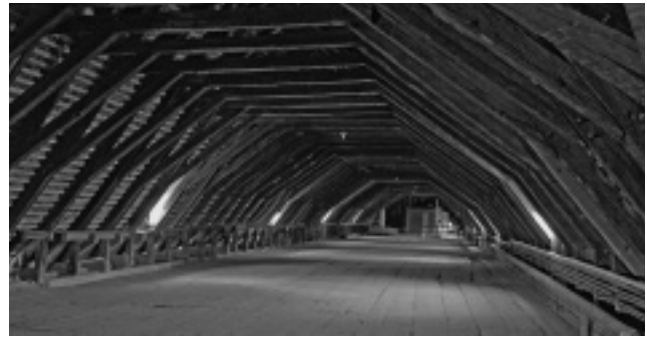
Abb. 17. Basel, Unterer Rheinweg 26, «Kleines Klingental». Blick ins originale, ins Jahr 1274 datierte Sparrendach, das den 70 m langen Dormitoriumsflügel überdeckt und ursprünglich nach einer konstruktiv nachweisbaren 90-Grad-Abwinklung den Querflügel rheinaufwärts ebenfalls überdacht hatte. Foto Basler Denkmalpflege.
