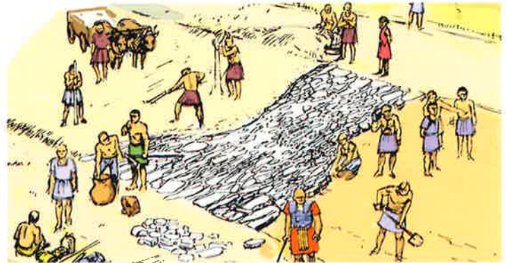
Römische Legionäre bauen im 1. Jh. n.Chr. in der Region eine Strasse. Zeichnung T. Yilmaz, Office de patrimoine historique du Canton de Jura.
