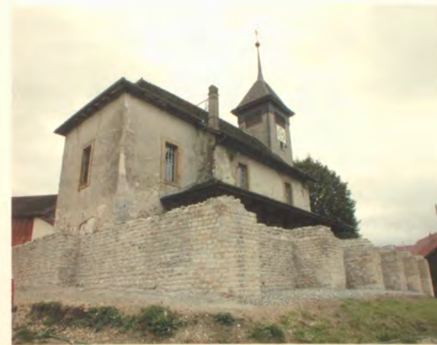
Fig. 421 Ursins. On ne sait toujours pas à quelle époque la première église fut construite à l'emplacement du temple à péribole gallo-romain. L'église actuelle a été reconstruite en 1702.
